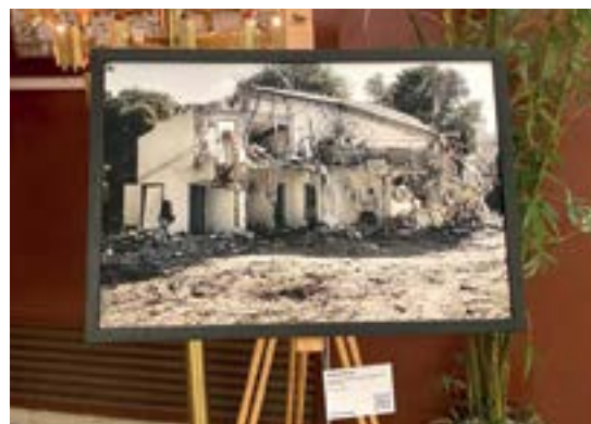
In alto: una fotografia del Kibbutz Be'eri scattata da Sofia Tranchina ed esposta nel Tempio di Via Guastalla il 7 ottobre.
